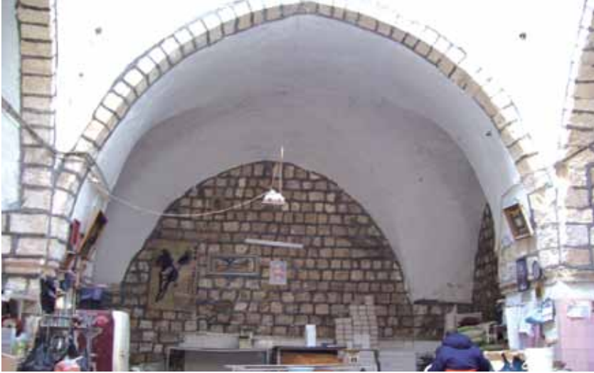
شكل رقم (34): المشلع الصيفي في حمام القاضي ويظهر الجزء الخلفي المسقوف بقبو مصلب.
