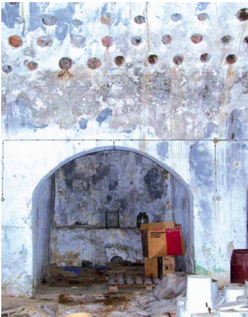
شكل رقم (38): الغرفة الحارة او قاعة الاستحمام في حمام القاضي وتظهر الفتحات الموجودة في السقف
