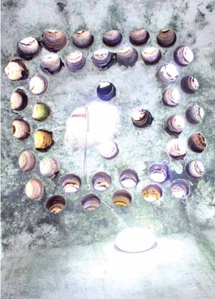
شكل رقم (28): سقف يحتوي على فتحات للاضاءة في حمام الجديدة
