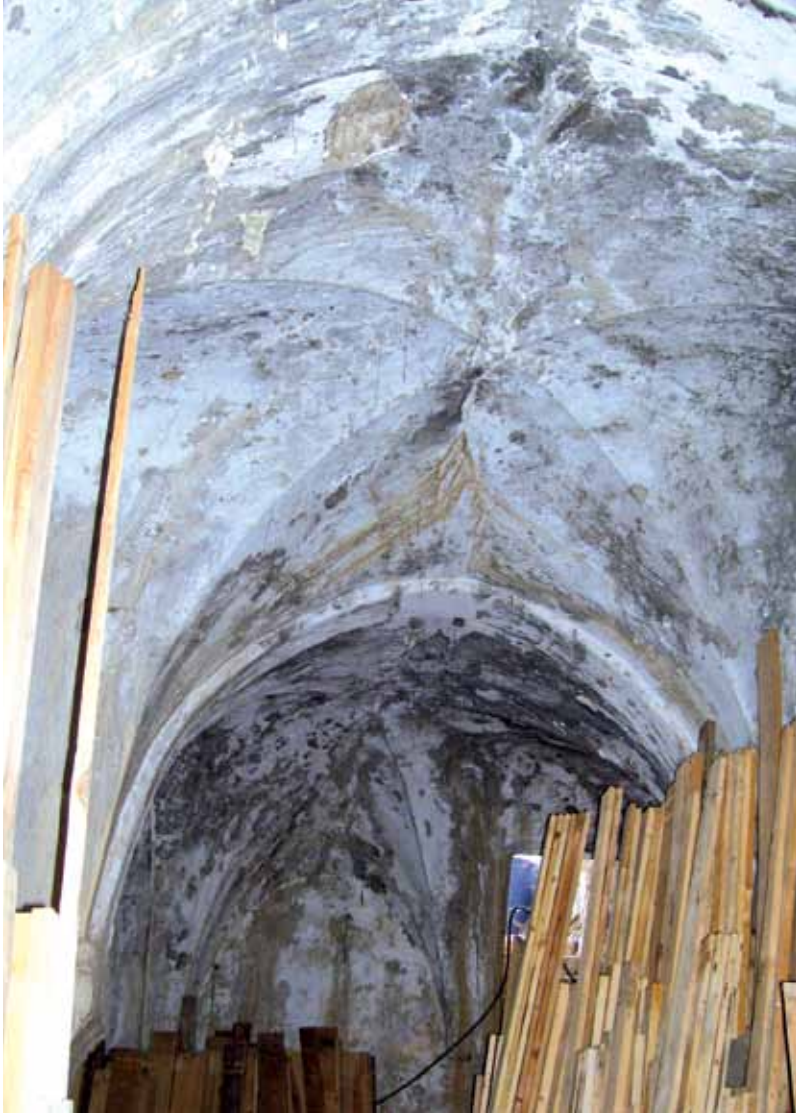
شكل رقم ( 15 ) : الاقبية المصلبة في المشلح الصيفي
