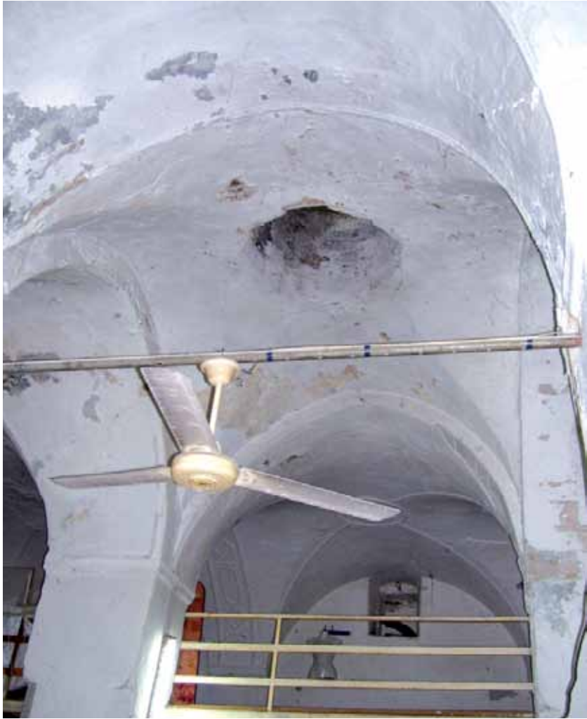
شكل رقم (41): فتحة مستديرة في القبو المصلب المركزي للاضائة
