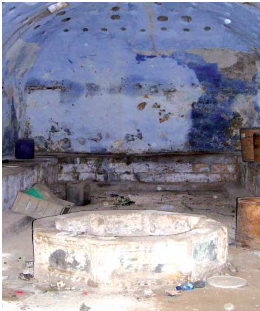
شكل رقم ( 5 ): المشلح الشتوي في حمام القاضي وتظهر في السقف الثقوب المغطاة بالزجاج والمقاعد الحجرية حول الغرفة وبركة الماء في وسطها
