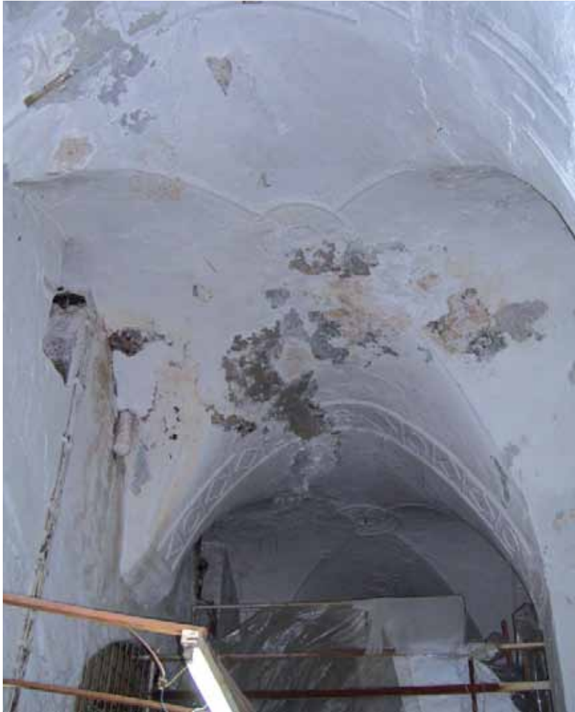
شكل رقم (40): الاقبية المصلبة في سقف حمام التميمي وتظهر ايضاً بعض الزخارف
