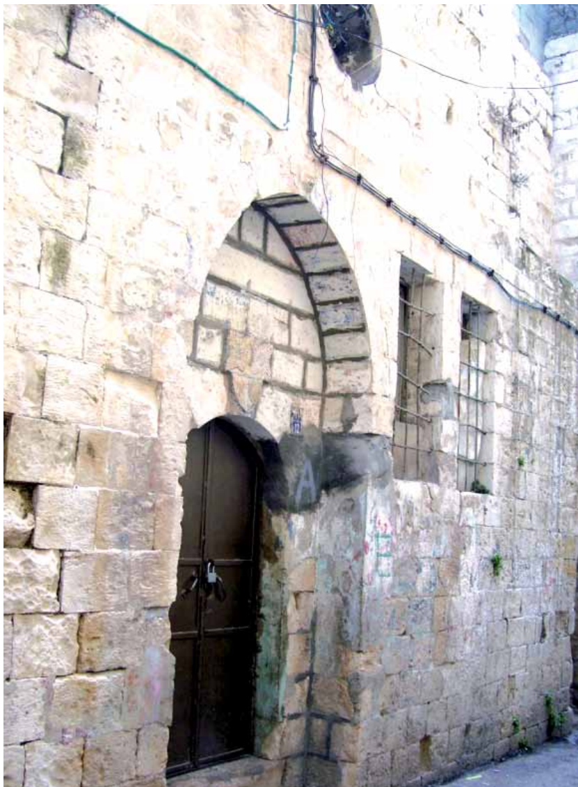
شكل رقم (33): المدخل الرئيسي في حمام القاضي
