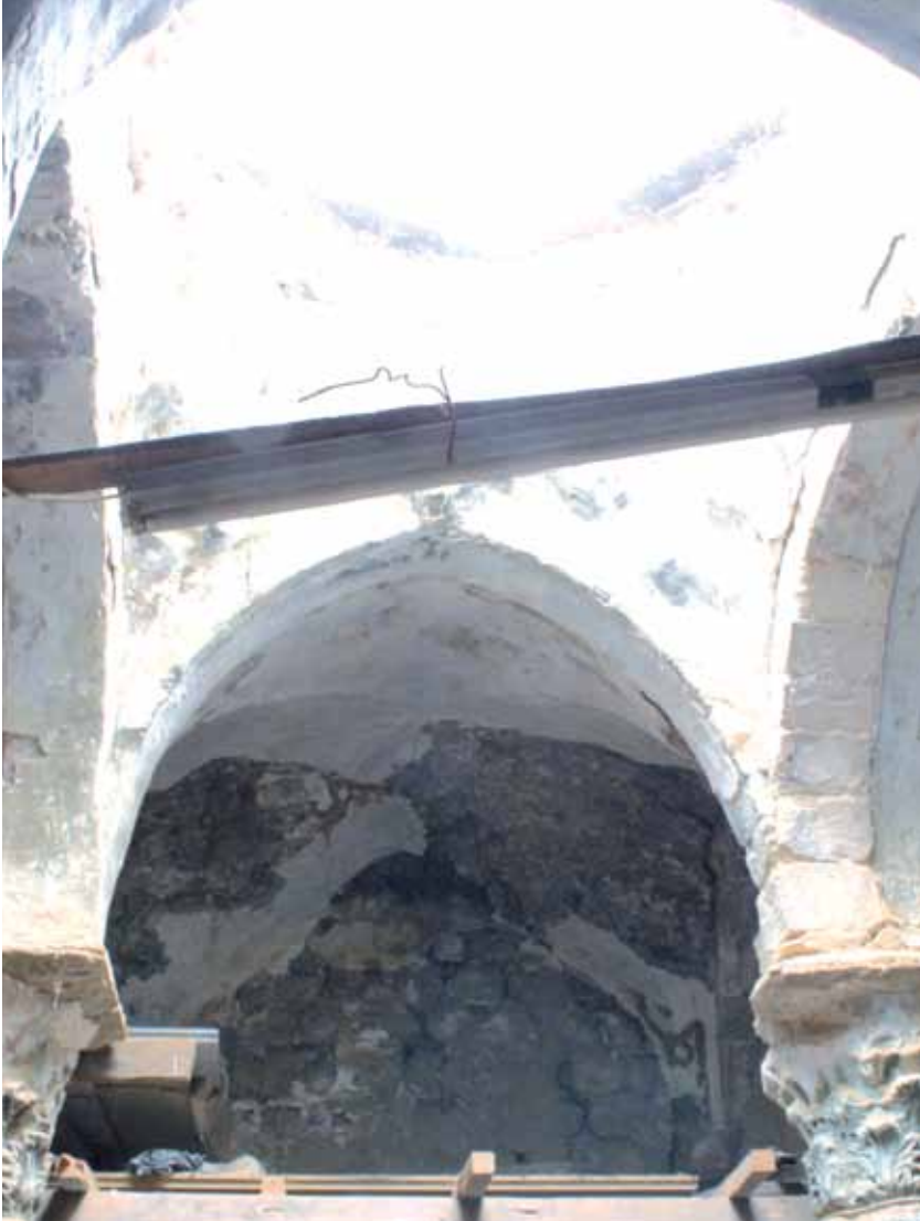
شكل رقم ( 12 ) : الفتحة المركزية في سقف المشاح الصيفي في حمام الببيدة
