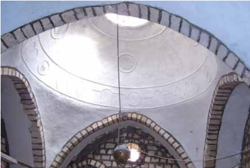
شكل رقم (35): القبة المركزية في المشلع الصيفي في حمام القاضي وتظهر زخارف القبة والفتحة المركزية فيها.
